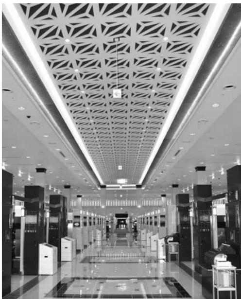
メイン通路の幅は4.4m、天井の最高は最大で5.8m。天井には小さい穴が無数に開いている吸音ボードを使用。10デシベル程度の抑制を見込んでいる
