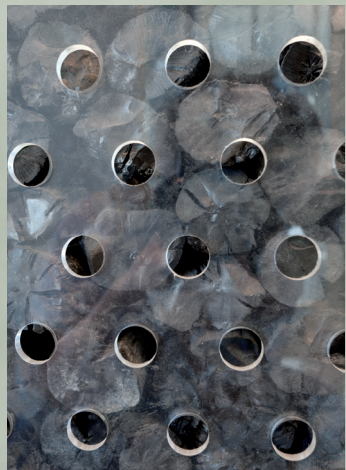
喫煙室の壁には消臭・除菌効果がある木炭 が敷き詰められている
